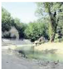
I lavori a San Severino
